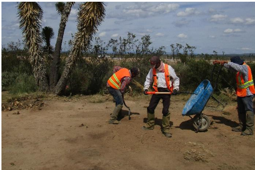
Figura 71. Trabajos para tapar la unida de excavación en sitio P.S.T. 1 El Tulillo.
